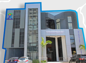
Edificio Seminario (Santo Domingo)
